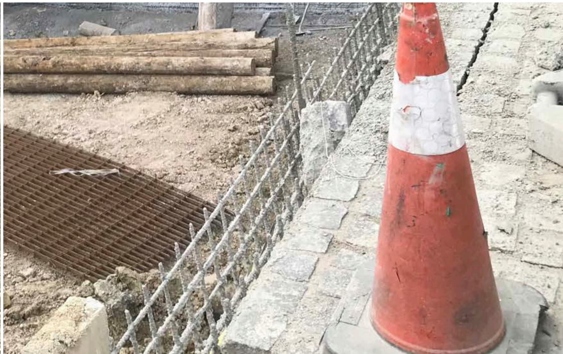
Janvier 2019 - Terrassement et voiles contre terre
