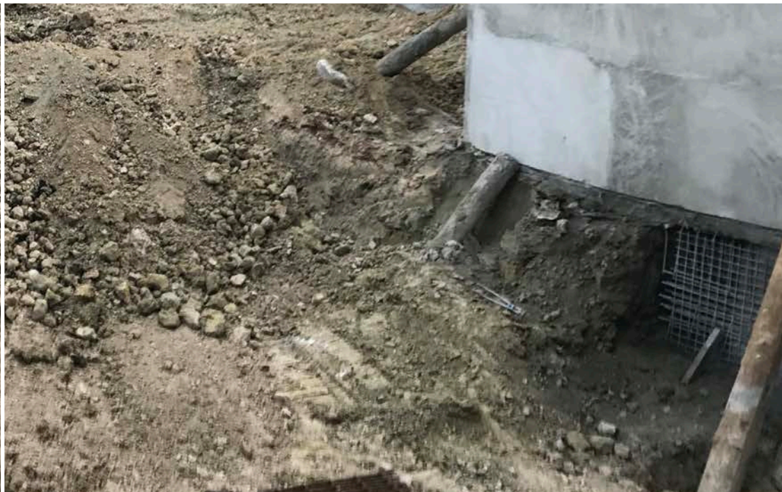
Janvier 2019 - Terrassement et voiles contre terre
